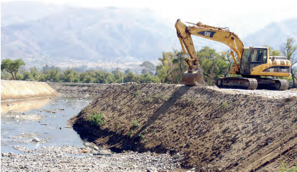
Foto 16. Acondicionamiento hidráulico en el sector de Pico de Loro-Vinto- Fase I.
