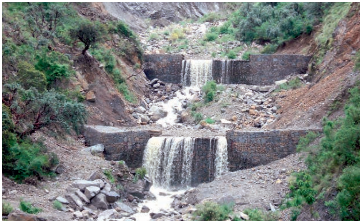
Foto 15. Gavión construido en la cuenca Thola Pujru
