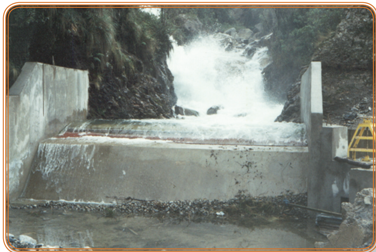
Fotografía N° 7 Toma tirolesa sobre el Canal Palca en la subcuenca de Potrero Mayu
