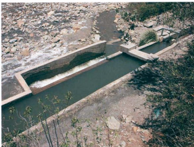
Figura 15.3: Desarenador con vertedero que descarga hacia el cauce natural
