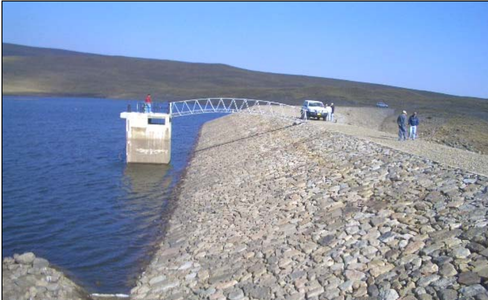
Presas de tierra Chankas y obra combinada de vertedor y toma en la cordillera del Tunari, Cochabamba.
