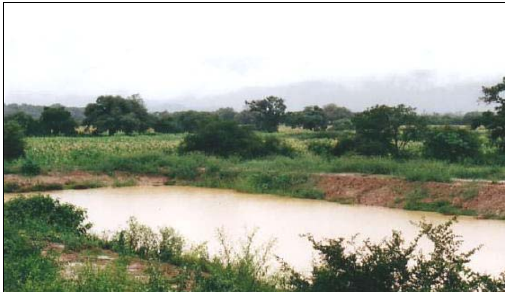
Atajado de 3.000 metros cúbicos que capta aguas de crecidas, en Pampa Redonda, Santa Cruz.
