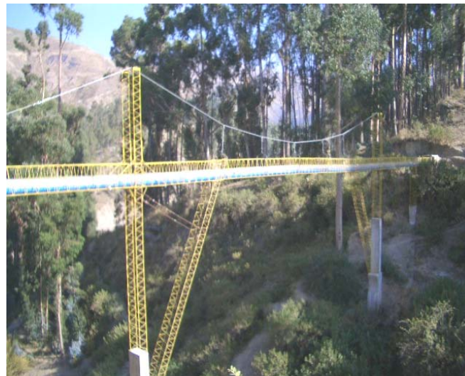
Estructura de cruce de quebrada con tubería, Palca, La Paz
