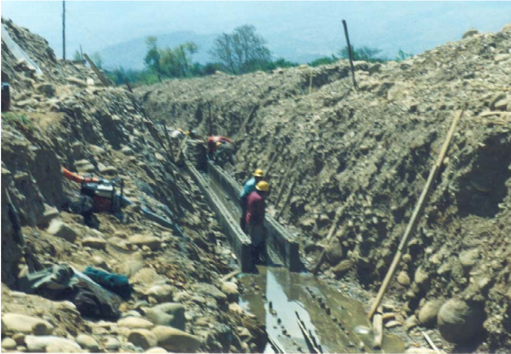
Galería filtrante en construcción en Calamuchita, Tarija
