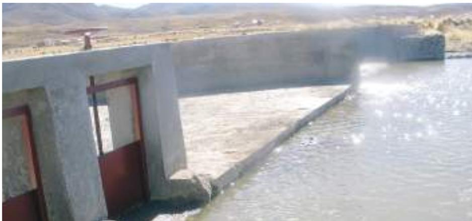
presa para registrar el nivel del agua. Hasta su retorno, los presentes se dedican a determinar el nivel del agua en base de los datos de tiempos y caudales de salida, utilizando la curva altura – volumen de la presa. Al final de la sesión, se compara el nivel teórico con el medido y se define si hay necesidad de ajuste en el plan de operación de la presa.
