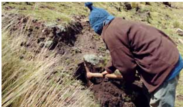
Foto 26: Excavación de hoyos en una ladera
