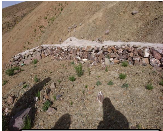
Vertedor de atajado con piedra laqueada
