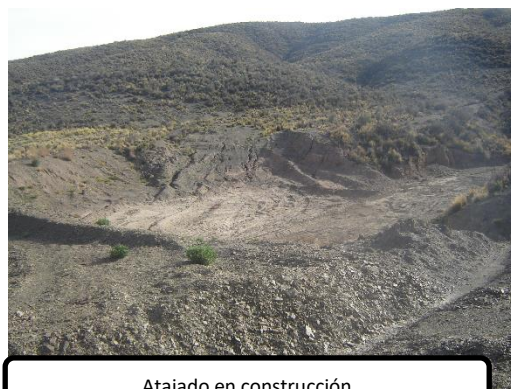
Atajado en construcción
